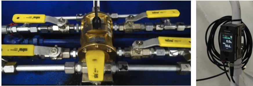
Figuur 6 Voorbeeld van een digitale brandstofsensor op een hoofdmotor in de Belgische visserij (links) en van een AmendTec 'clamp-on' sensor die binnenkort zal worden uitgetest in de Nederlandse Visserij (rechts).
